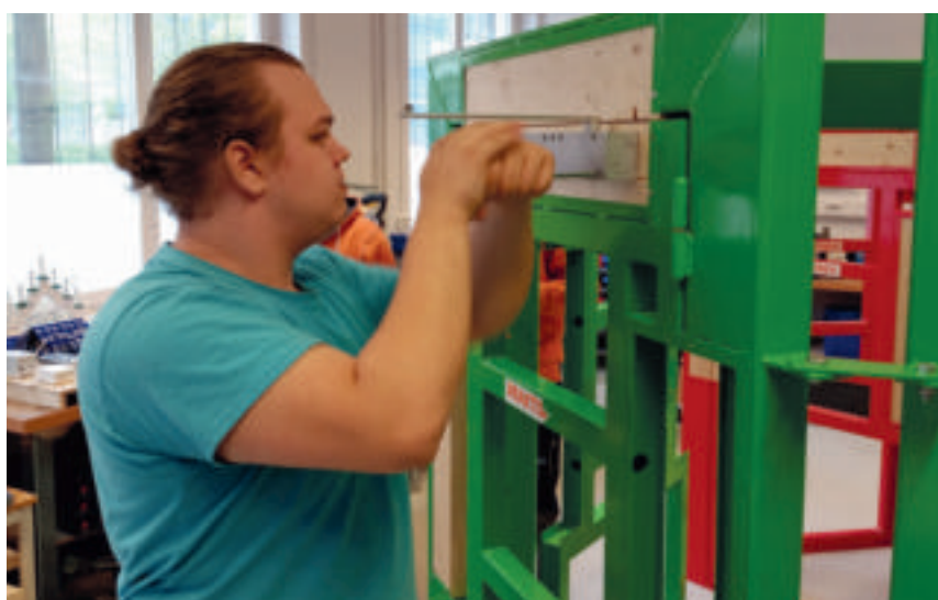
Dörrstängare under montering. Kevin från Örebro ser till att det blir korrekt gjort.
