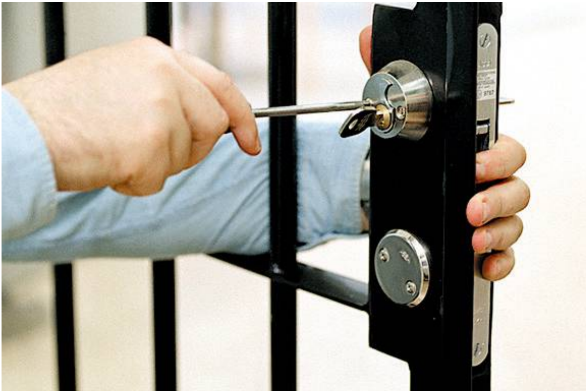
LÅSFIX. Montering av säkerhetsslås.
